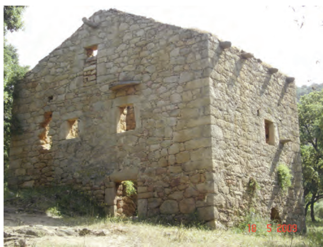
La ruine de Fica, datant de 1786, en FT Chiavari
